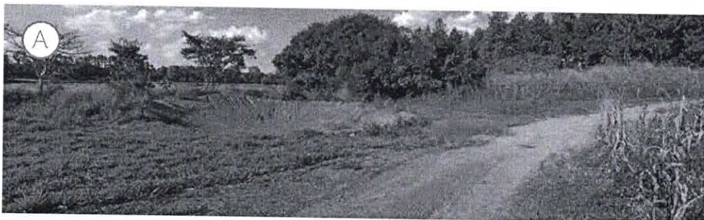
Figura 9 – Associação de lombadas no leito e de terraços nas laterais da estrada integrando o sistema de drenagem superficial, desviando a água para as áreas marginais.
