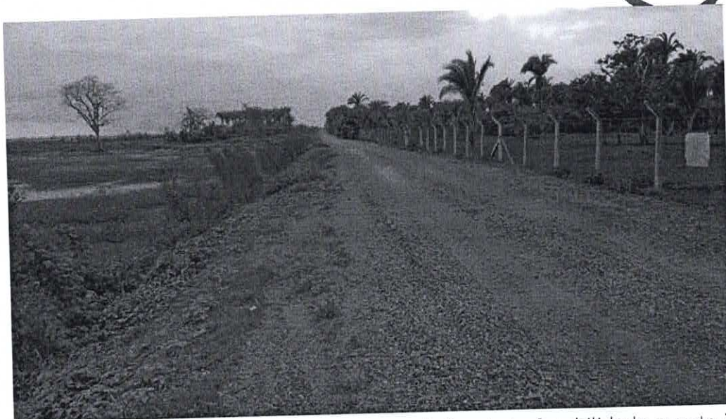
Figura 6 – Detalhe de Estrada com boas condições de trafegabilidade quanto à qualidade do leito e de visualização.
