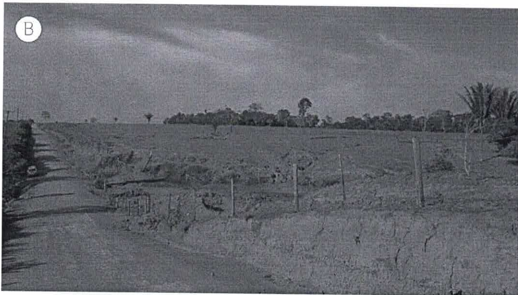
Figura 1 – Processos erosivos na lateral da estrada (A) e em área de pastagem (B)
