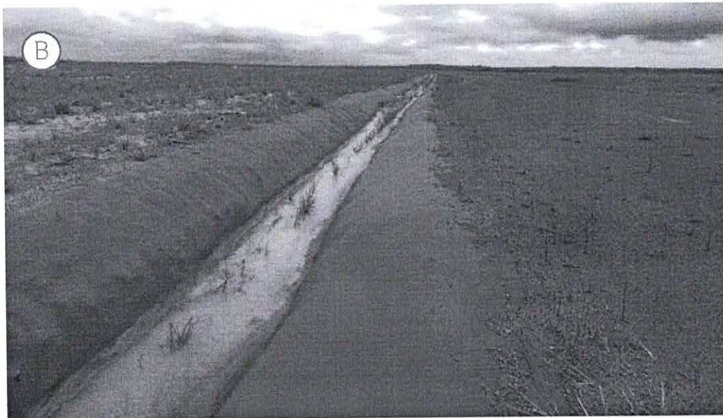
Figura 8 – Detalhe de passagem da drenagem pluvial sob a estrada (A) e da condução ordenada do fluxo superficial da drenagem em canal lateral revestido de manta bidim. (B).
